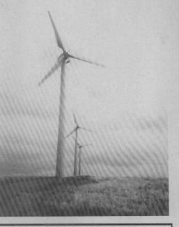
Das Konzept der AN-Bonus 150/30 kW Windenergieanlage – Rotor mit horizontaler Achse, Rotorblätter mit festem Anstellwinkel, ein Generator( polumschaltbar 150 bzw 30 kW), Netzparallelbetrieb, Stall-Regelung – ermöglicht die wirkungsvolle Windenergienutzung bei geringem Wartungsbedarf. Alle Komponenten sind großzügig dimensioniert, sorgfältig aufeinander abgestimmt und haben einen hohen Qualitätsstandard. So erreichen wir eine lange Lebensdauer.
